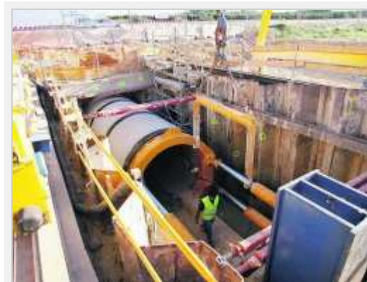
TRASVASE. Un operario, en las obras de la conducción del Júcar al Vinalopó. /IRENE MARSILLA
