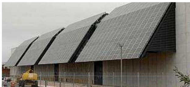
El edificio de la desalinizadora está listo desde hace casi un año : la espera de las tomas que eleven hasta las instalaciones el agua de mar. TIPO:
