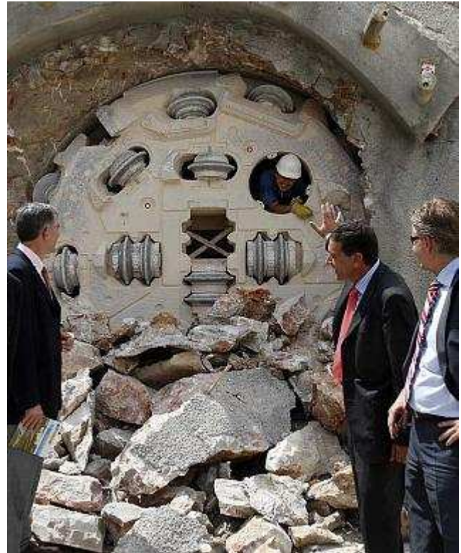
Puxeu, al fondo a la derecha, observa una perforación del trasvase INFORMACION
