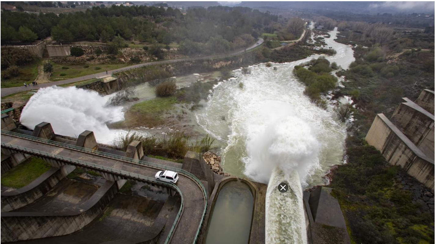
Desagüe de la presa de Bellús la semana pasada tras el temporal de lluvias. PERALES IBORRA
