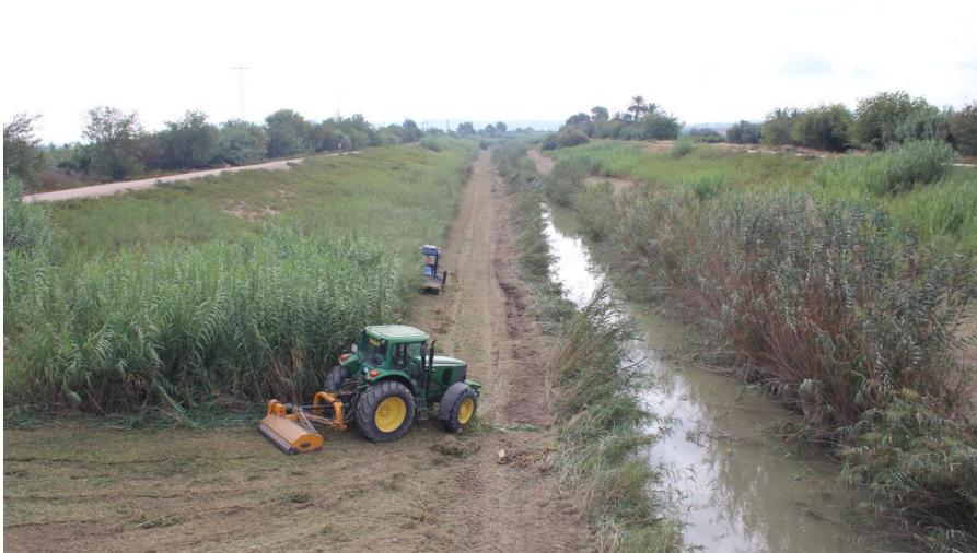
Trabajos de mantenimiento en el cauce del Segura a su paso por Molins INFORMACIÓN
