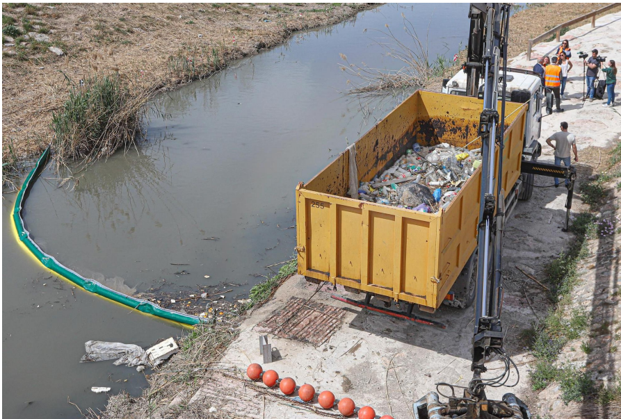
Instalación de una barrera de flotantes en el río Segura en Orihuela. TONY SEVILLA
