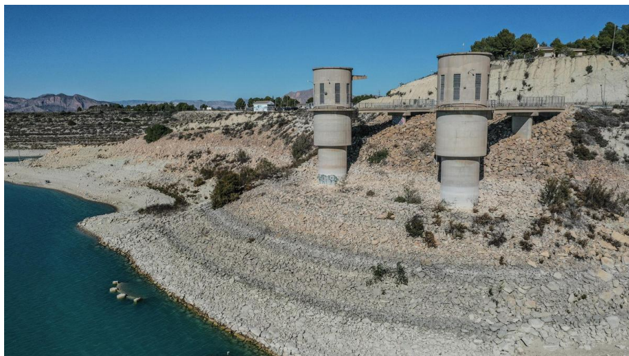
Imagen reciente del pantano de La Pedrera en Orihuela, que está bajo mínimos. TONY SEVILLA
