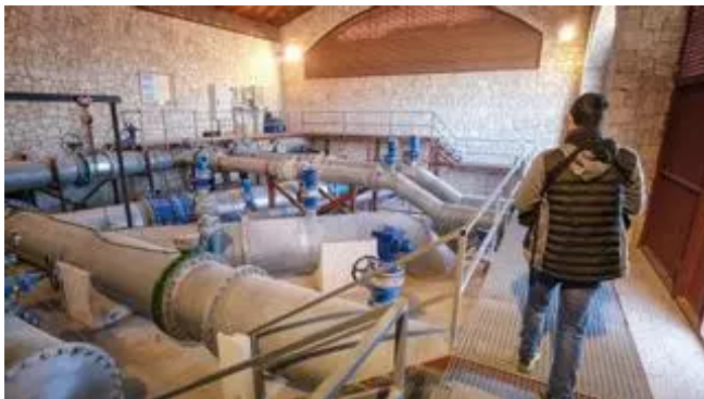
Imagen de la red de tuberías de la balsa del Toscar para la distribución de los recursos del trasvase del Júcar. / AXEL ÁLVAREZ
