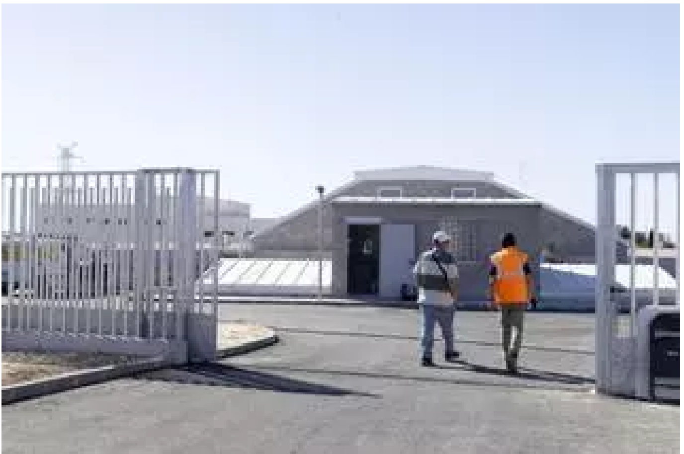
Acceso a los depósitos que se han levantado en la parte trasera de la desaladora / PILAR CORTÉS
