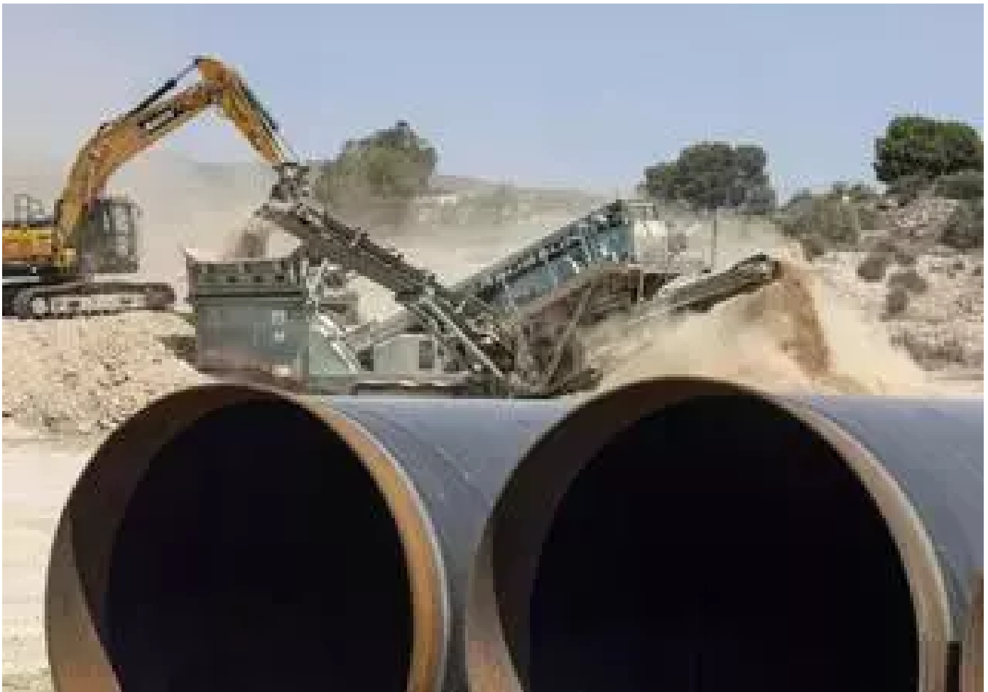
Obras del postravase Júcar-Vinalopó / ALEX DOMÍNGUEZ
